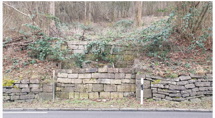
Zugemauerte Reste des Eiskellers - auf dem etwas sichtbaren Torbogen ist die Jahreszahl 1873 und der Name Adolf Unger eingemeißelt
