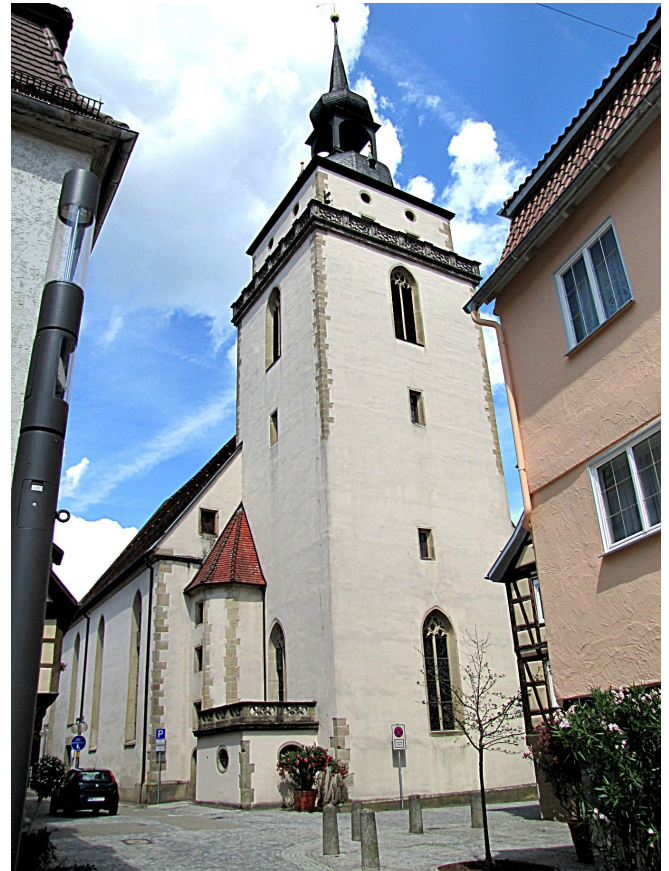
Blick von der Hauptstraße auf die Stadtkirche
