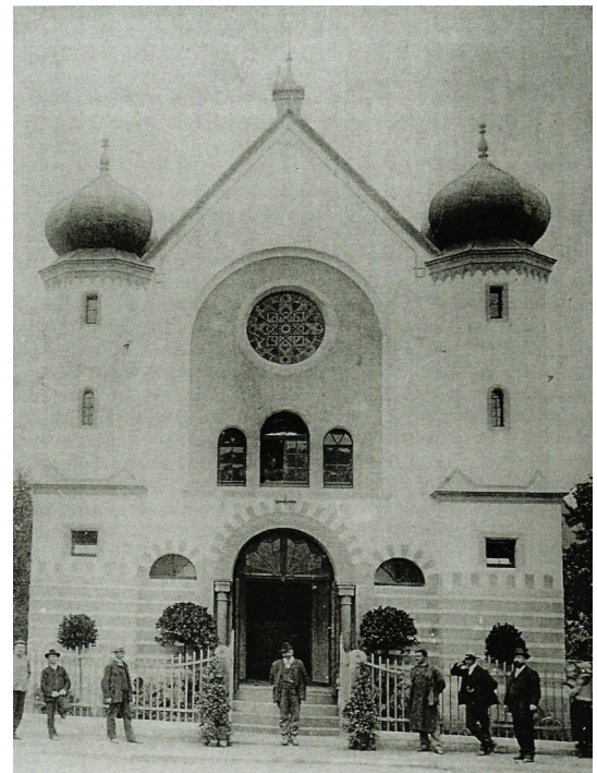
Kurz vor der Einweihung ein Foto mit den beteiligten Handwerkern: v.l.n.r.: Steinhauer Wieland, Malermeister Rumm, Zimmermeister Heink, Werkmeister Glenk, Schlossermeister Heyn, Architekt Ganzenmüller, Schreinermeister Gollwitz
